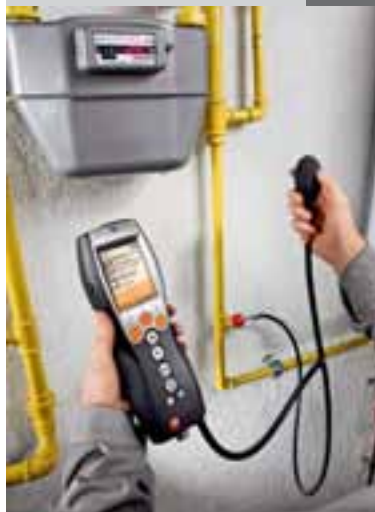
Проверка герметичности газовой трубы
